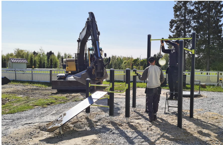
Leikki- ja liikuntavälineitä asennettiin talkoilla kesäkuun alussa.
